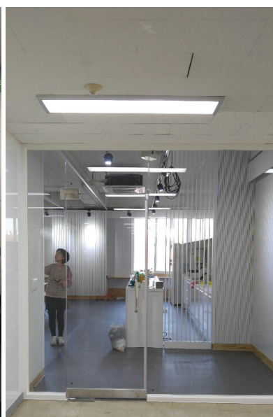
예제교회 입구(리모델링 후)
